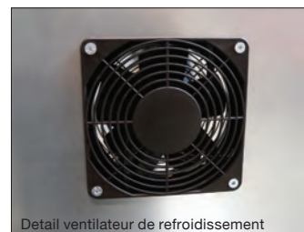
Detail ventilateur de refroidissement
