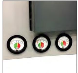
Chaque étape de filtration est munie d'un manomètre afin de vérifier la perte de charge de chaque élément filtrant.
