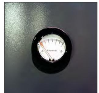
Pour un contrôle efficace de l'encrassement des filtres par manomètre de pression différentielle.
