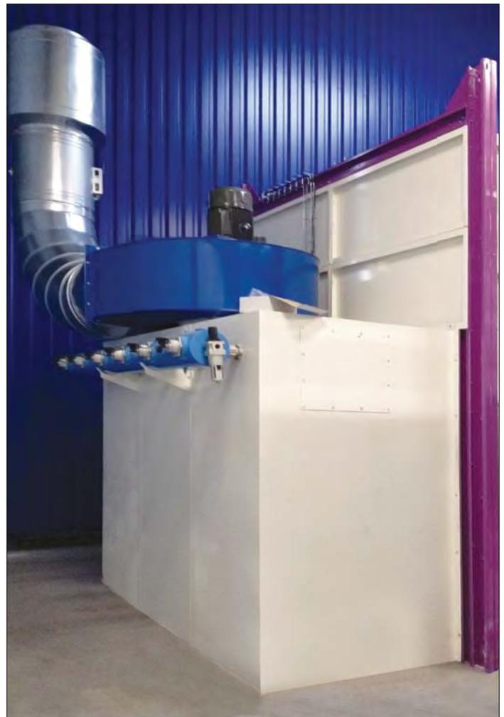
Vue du mur aspirant intégré dans la cabine de poudrage
